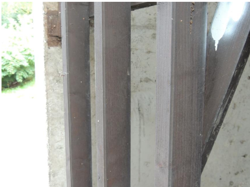
Zkušební místo pro stanovení pevnosti betonu Schmidtovým tvrdoměrem uvnitř podpěry
