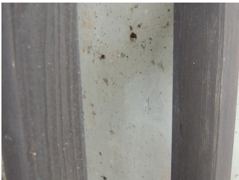
Zkušební místo pro stanovení pevnosti betonu Schmidtovým tvrdoměrem a hloubky karbonatace betonu uvnitř podpěry
